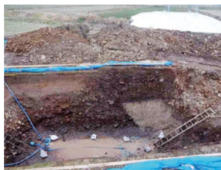
2016年熊本地震断層のトレンチ調査の様子
