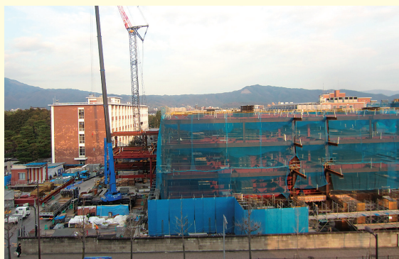
寒梅館より望む新棟工事。左端は比叡山と博遠館、 中央右は大文字山、その右は寧静館と扶桑館
